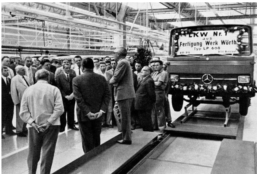
Zdj. 1Linia produkcyjna 1. pojazdu Mercedes-Benz LP 608 w zakładzie w Wörth, lipiec 1965 r.
